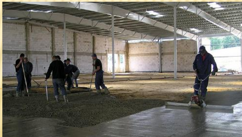
Rys.2. Wykonanie posadzki betonowej [24].
