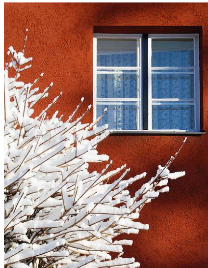
Abbildung 5.8: Typisches Kastendoppelfenster in der Hufeisensiedlung[DBINFO]
